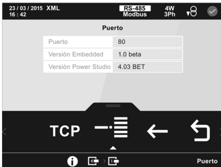
Figura 109: Pantalla de información del módulo Modbus Datalogger (Puerto)
